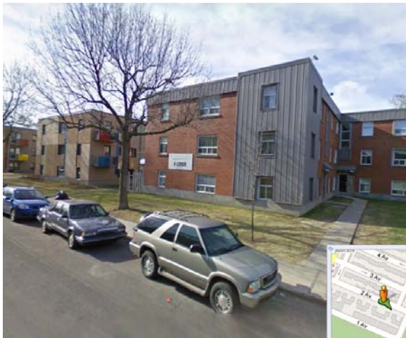
Logements de la SHDM, 2 ème Avenue entre Masson et Laurier
